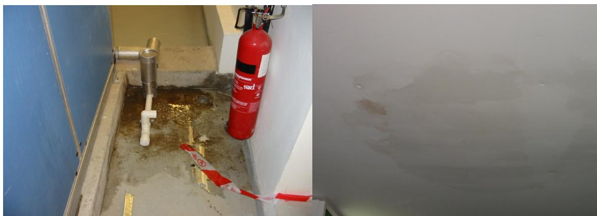
圖2.3b：鮮風入口設計欠佳而導致百葉窗後積水
