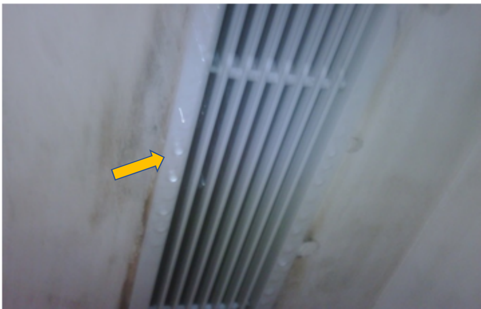
圖2.2a：空氣擴散器表面的冷凝水
