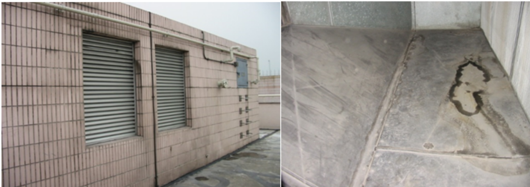
圖2.3b：鮮風入口設計欠佳而導致百葉窗後積水
