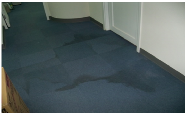
圖 2.3c：地毯上因過去的水患破壞而造成的水漬
