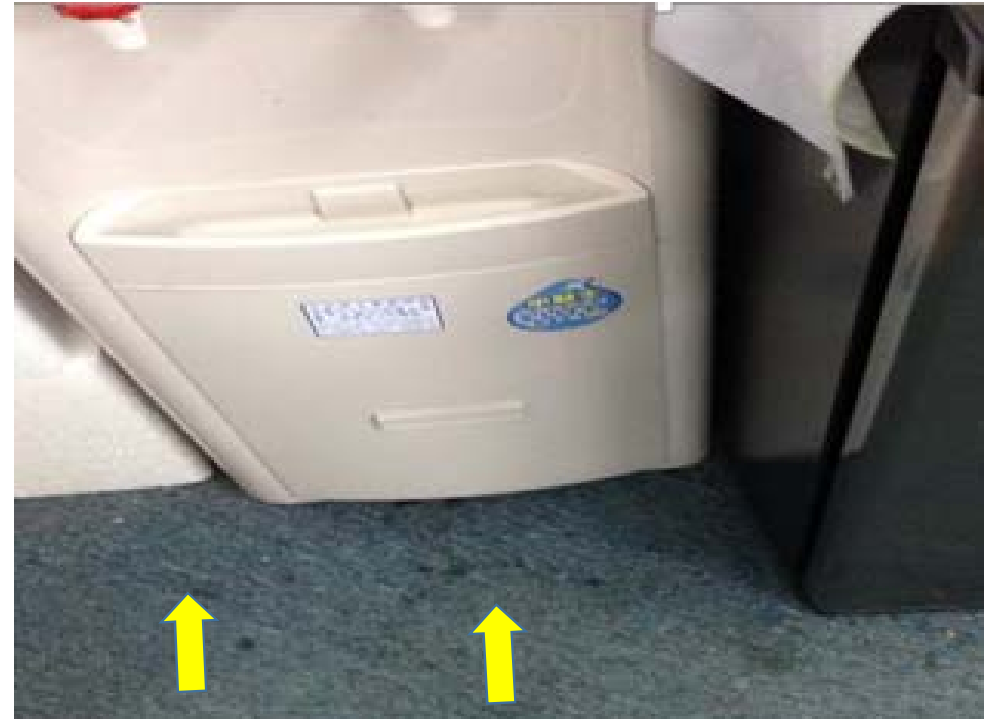
漏水的飲水器附近的地毯
