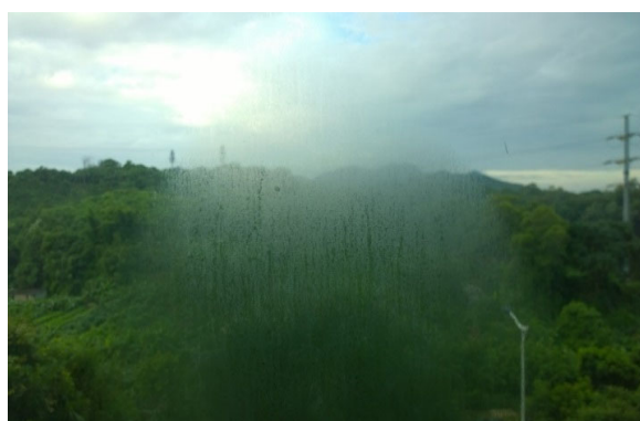
圖2.2b：窗格玻璃上的冷凝水
