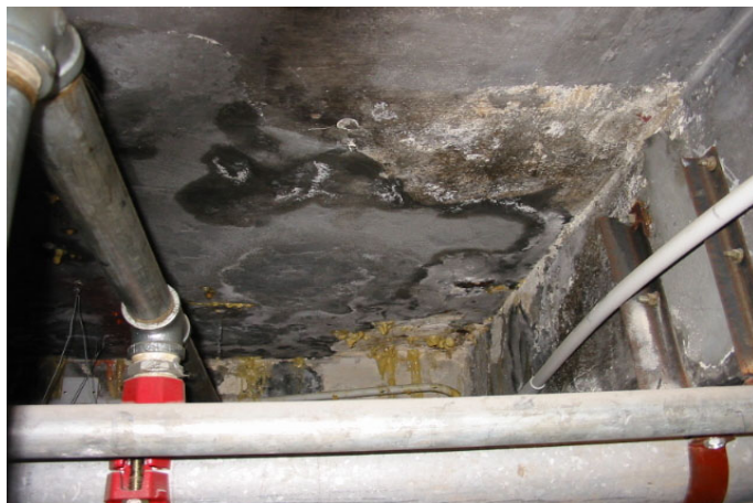
圖 2.3e：位於不能緊閉的門旁邊而曾受水患破壞的天花
