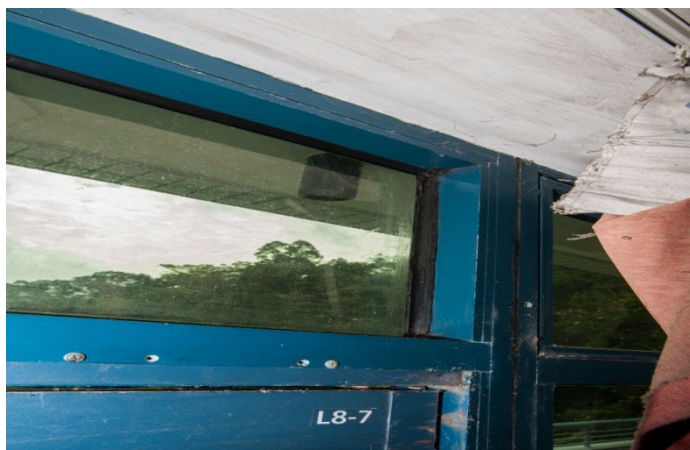
圖 2.3e：位於不能緊閉的門旁邊而曾受水患破壞的天花
